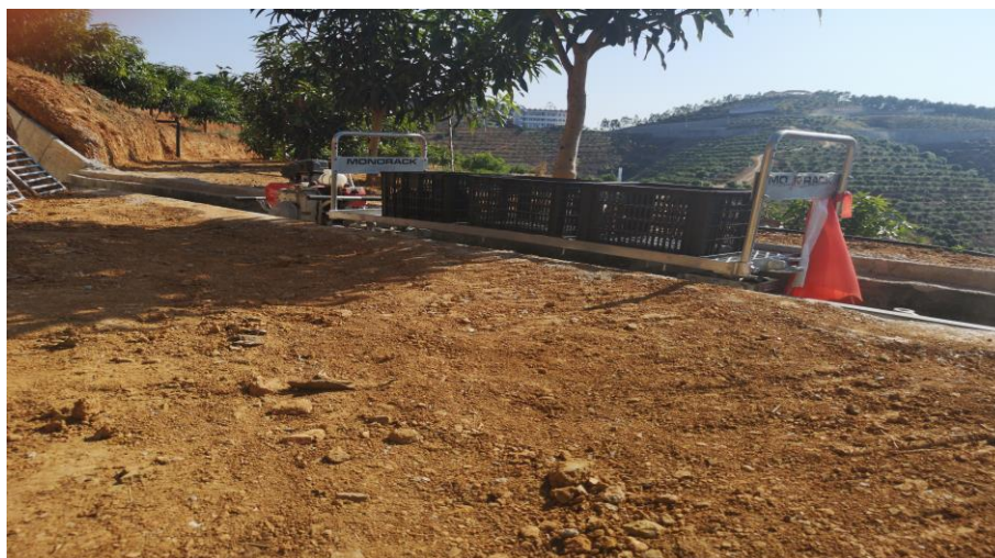
图3 改造完成后轨道沉降，不影响农机具的通行作业
