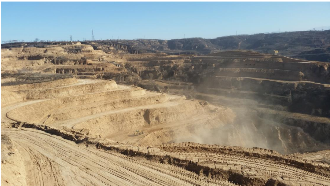
施工作业现场
