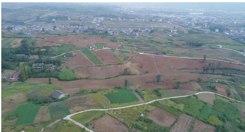
改造后航拍全貌
