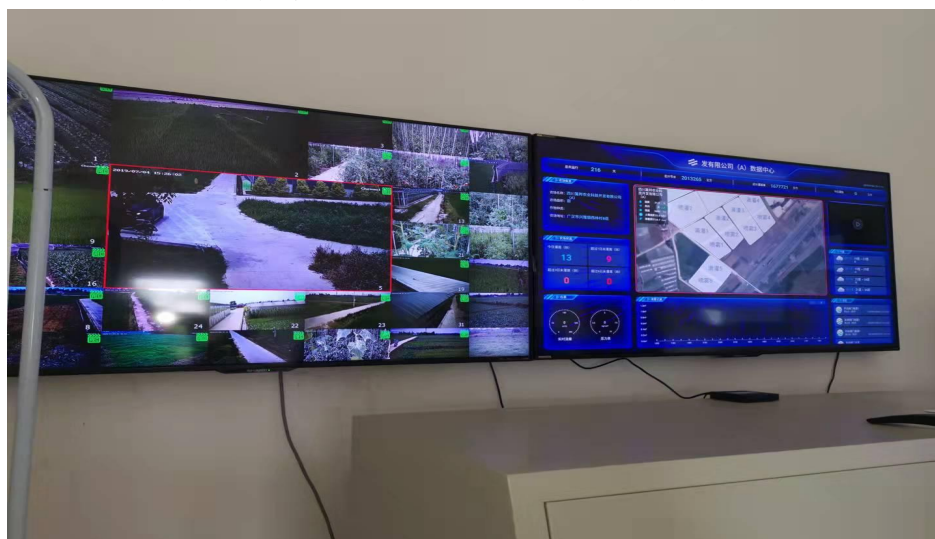
智慧灌溉控制中心
